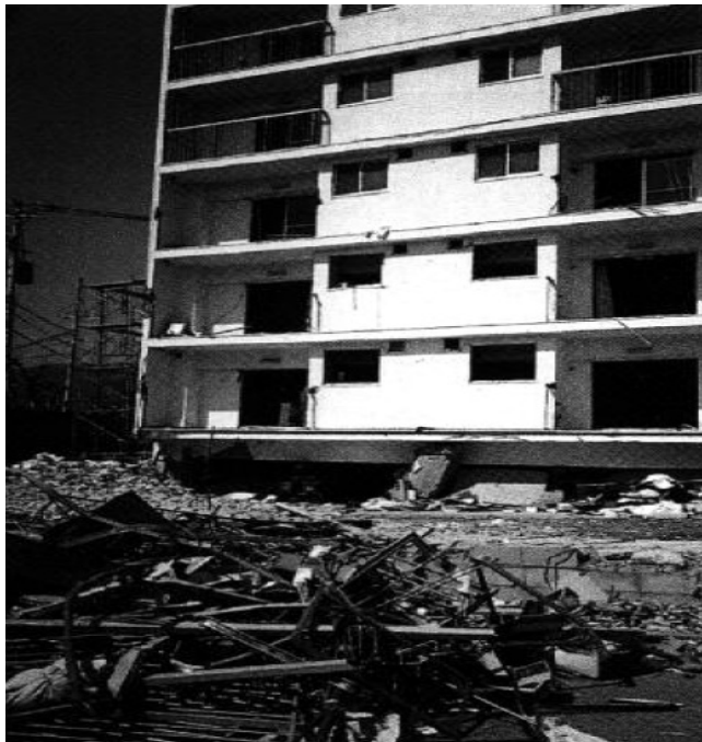
Figura 1.1.3.3 – Crollo del piano terra a pilotis
