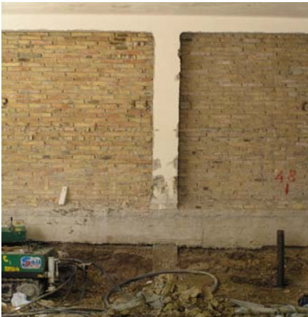
Figura 2.1.2.1 – Murature sul Piano seminterrato (PSI)
